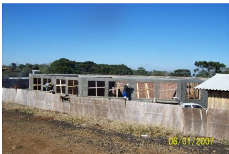
Construção da nova Escola Estadual Em forma de Oca.
